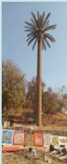
Pylône arbre Gorée
